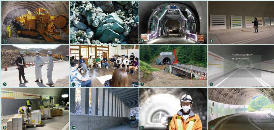
①トンネル掘削状況/機械掘削(2020) ②掘削現場地質/翡翠色の凝灰岩(2022.4月) ③坑内覆工コンクリート打設機稼働(2022.4月) ④カラータイル視認性実験(2021.12月.本名トンネル坑内にて) ⑤事業者と工事管理者(2022.4月.トンネル現場前にて) ⑥市民対話ワークショップ「哲学カフェ」(2022.7月.喰丸小にて) ⑦昭和村側:明かり部の九九竜沢橋(2022.8月) ⑧トンネル壁面シミュレーション(2022.6月) ⑨内装タイル設置工事進行中(2022.12月) ⑩会津美里町側:明かり部のアースシェッド松坂2号(2022.12月) ⑪工事現場主任(2023.2月) ⑫内装工事完了後の坑内から外を臨む(2023.8月)
