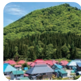
⑨トタン屋根の家並み 奥会津の特徴的な造りの家並みが上から見渡せます。
